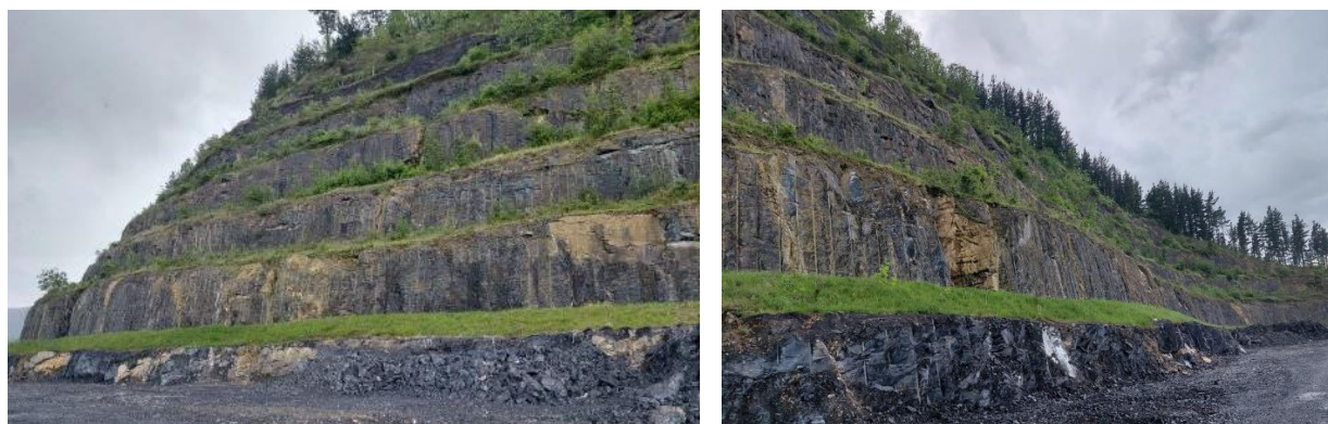
Foto general. Restauración
