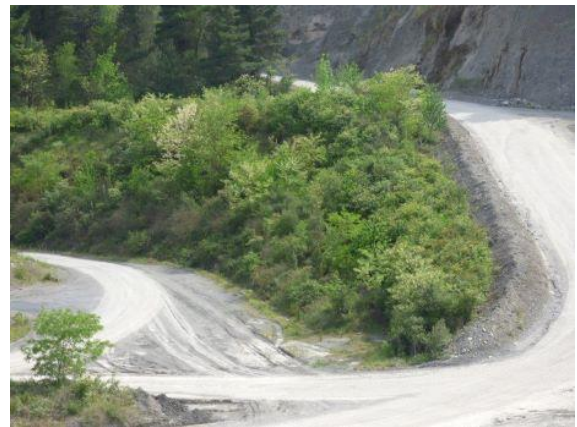
Estado restauración, año 2022
