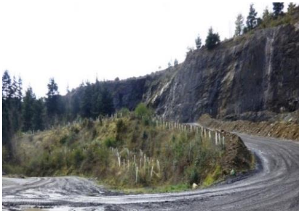
Estado restauración, año 2017
