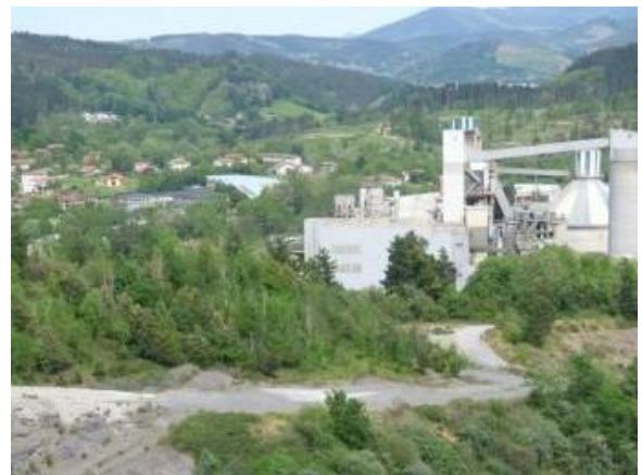
Estado restauración, año 2022
