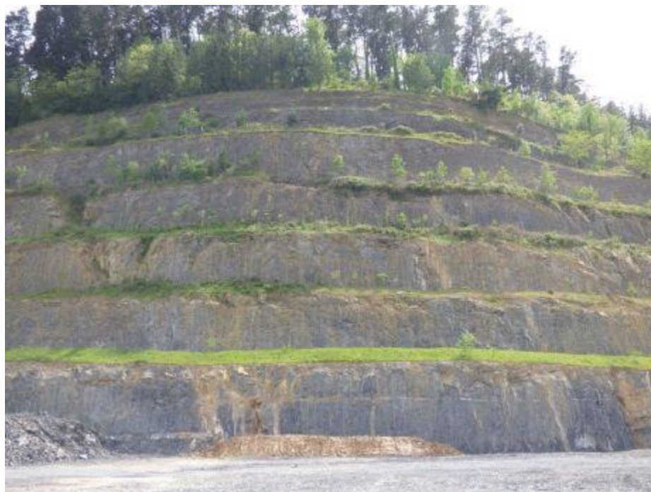
Foto general. Restauración
