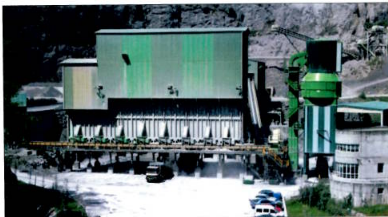
Fig 7- visual general de las instalaciones de trituración y clasificación capotadas.
