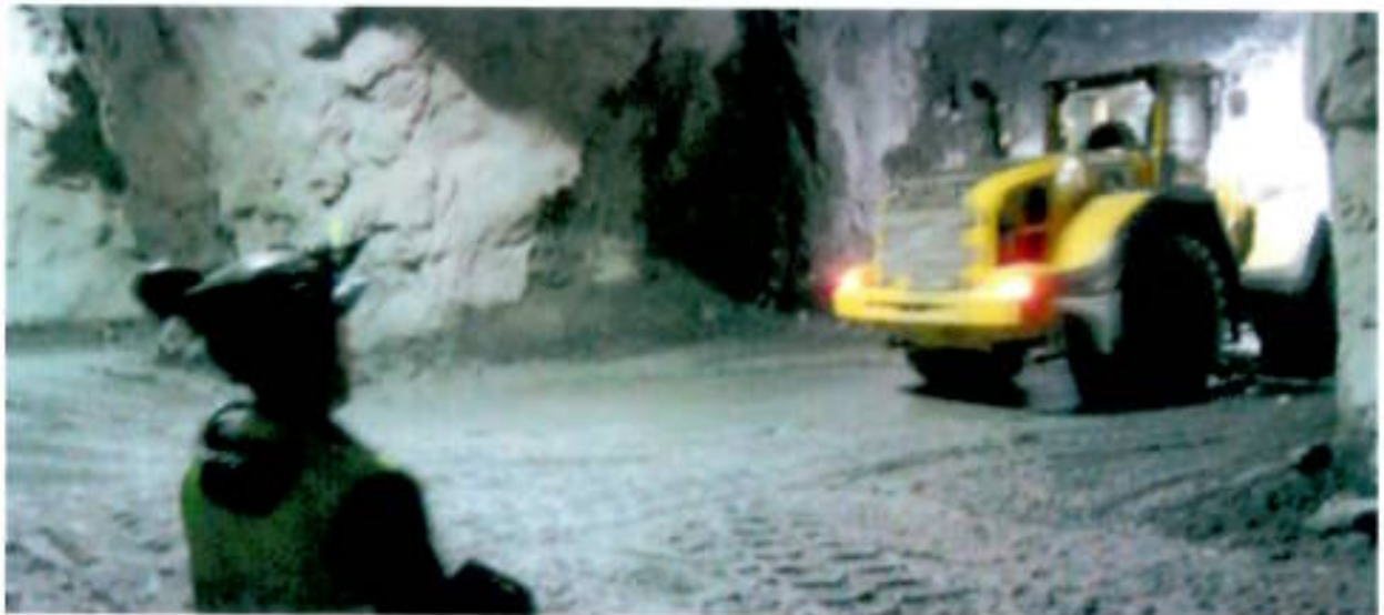
Fig 12- Pala Cargadora VOLVO 220 accionada por control remoto.(véase operario con mando a distancia en la esquina inferior izquierda). Cargando en recortes cámara C7 , nivel +135.Explotación subterránea.
