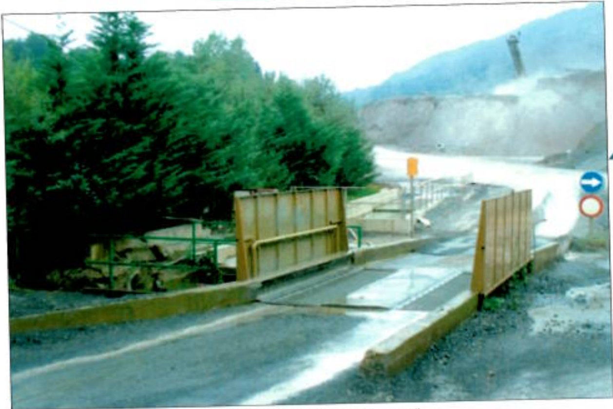
Fig4-Instalacion de lavaruedas en cantera Galdames II.
