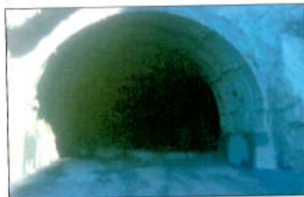
Fig. 11 emboquille galería pozo túnel.
