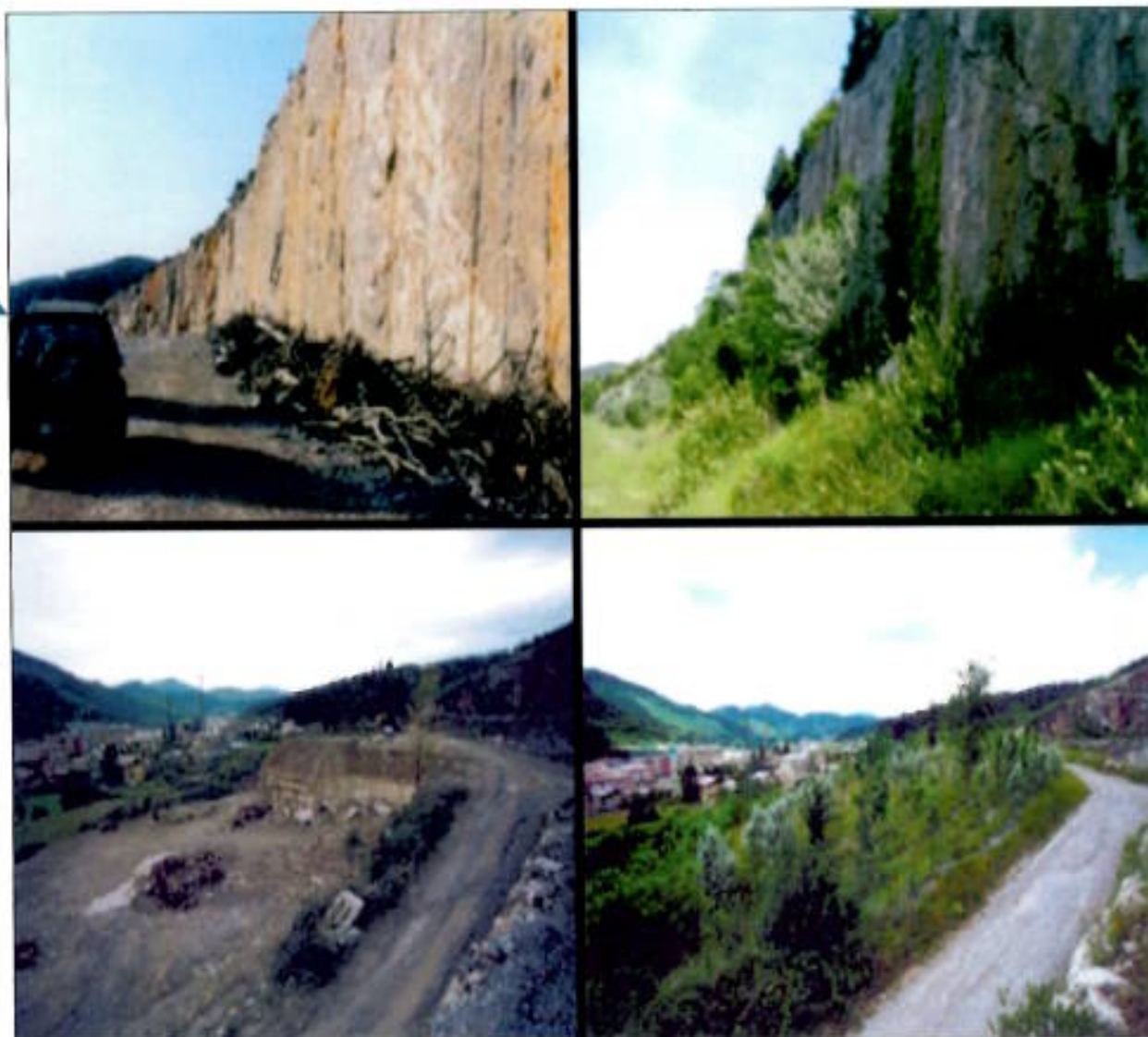
Fig.2 Estado bermas y plaza de cantera en 1996 y después de restauración año 2006.
