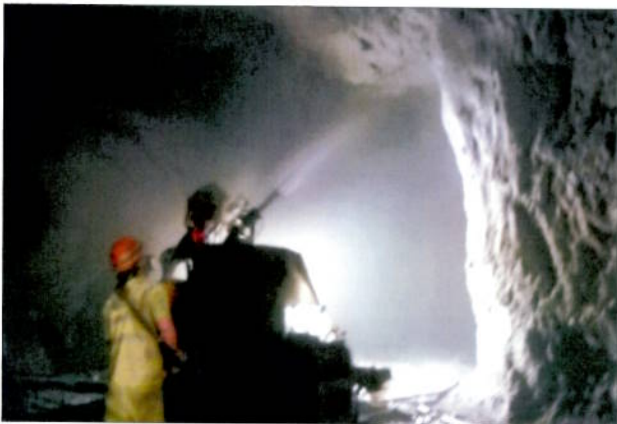
Fig 17- labores de gunitado de galerías. Explotación subterránea.
