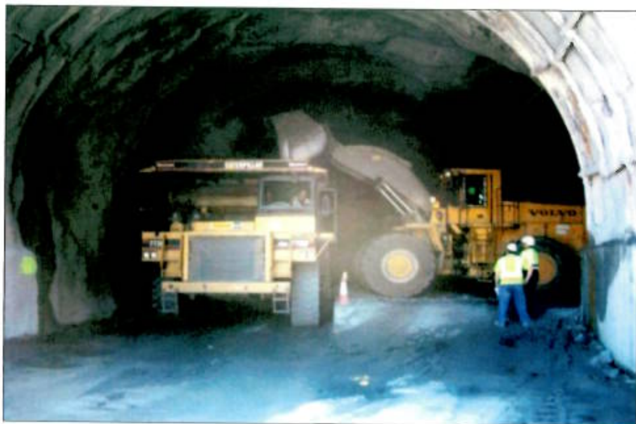
Fig 1- Operación de Carga en galería horizontal del sistema pozo túnel.
