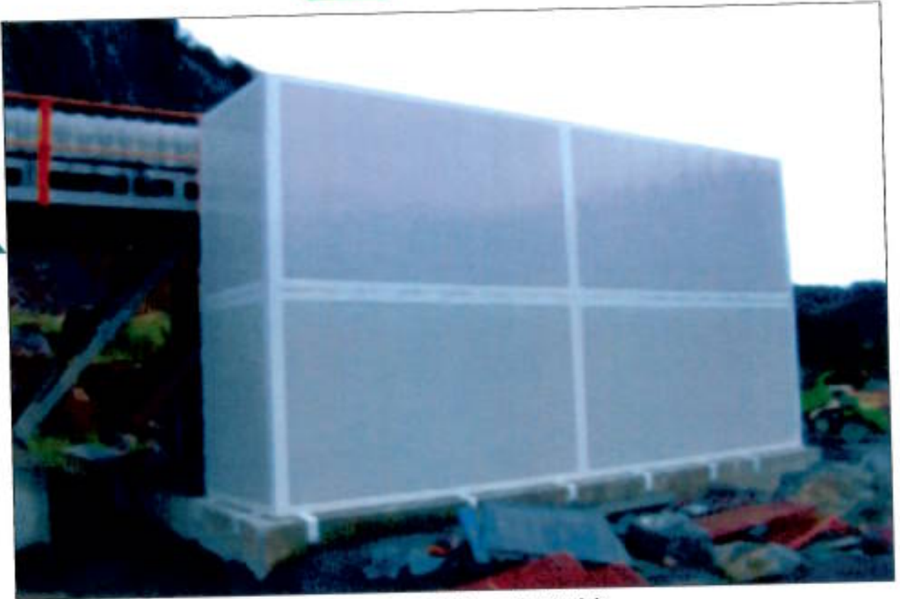
Fig6-Barrera sónica instalada en molino secundario.
