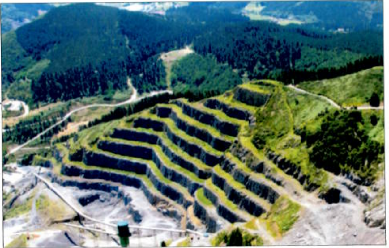
Fig11- Cantera de Apario en el año 2011. Se pueden observar con claridad los bancos restaurados en fase final, así como las zonas en explotación en la parte inferior centro y derecha.
