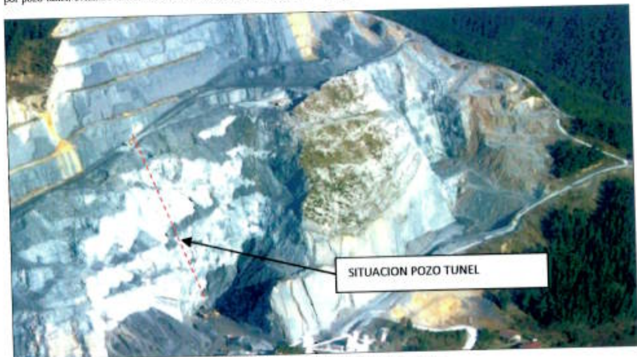
Fig. 1 Vista general de la cantera y situación pozo-túnel.
