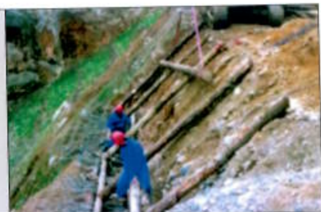
Fig 7. Aplicación de entramados tipo "Krainer" en la restauración de Peña Lemona.
