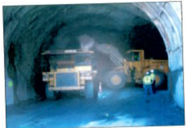
Fig. 2 Carga en el Pozo-túnel, con dumper Cat 773 y pala VOLVO 330.
