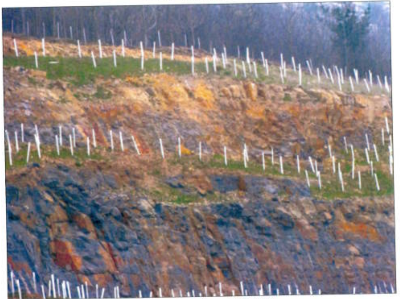
Fig10-Restauraciones en bermas cantera Galdames II.
