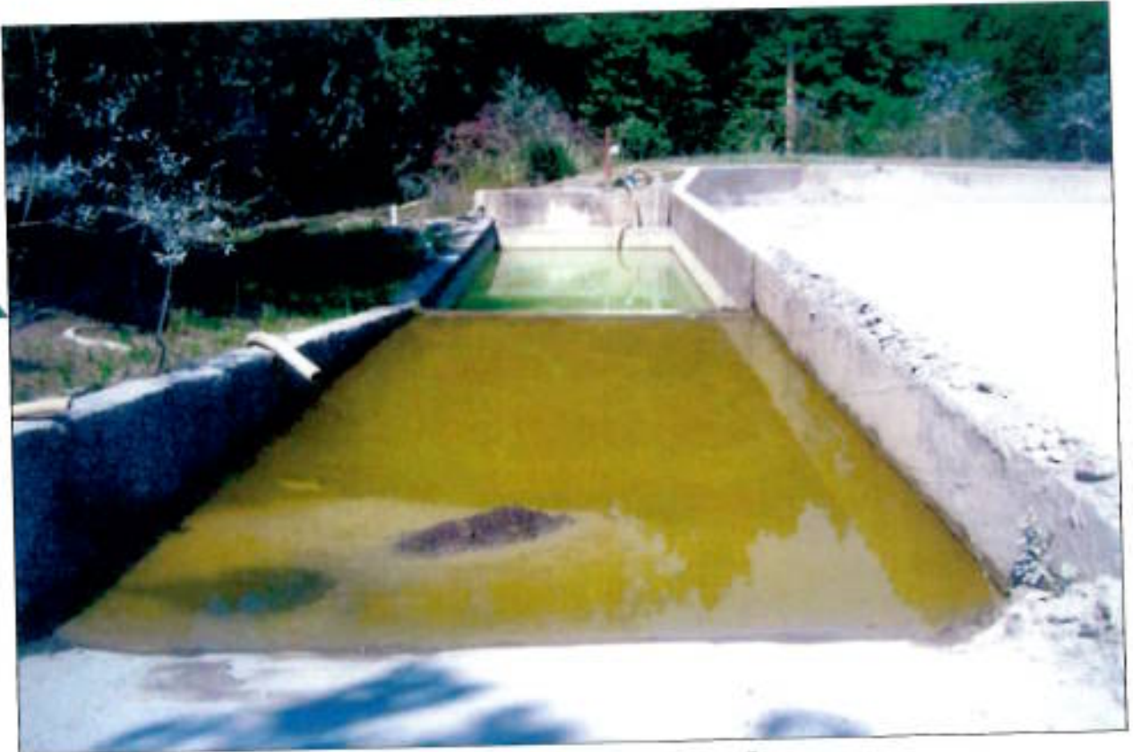
Fig3-Balsa de decantación en cantera Galdames II.
