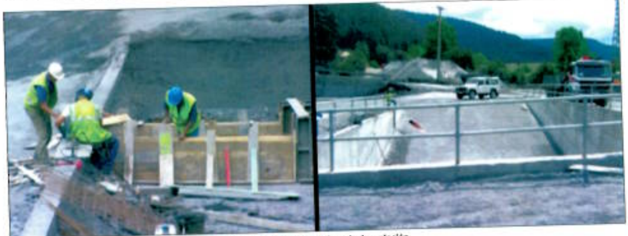
Fig. 3 Construcción de Balsas de decantación.
