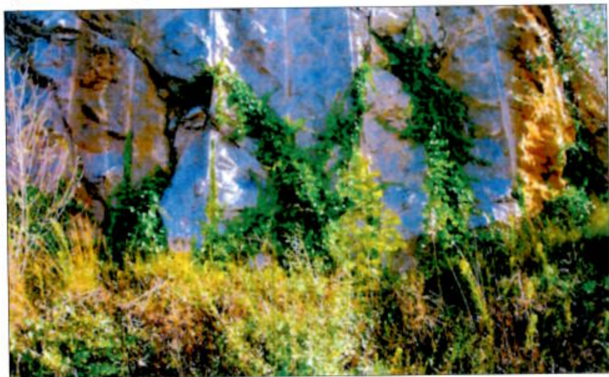
Fig 5. Frente restaurado; precortes plantaciones en bermas y trepadoras.
