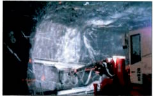
Fig 10- labores de avance en galerías en dirección. Explotación subterránea.
