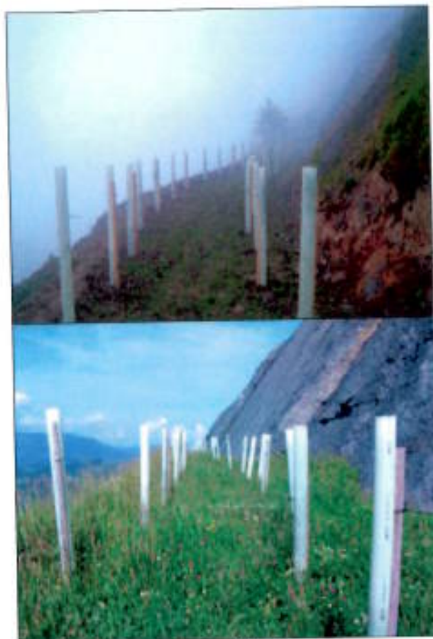
Fig. 10 Restauración en Bermas.
