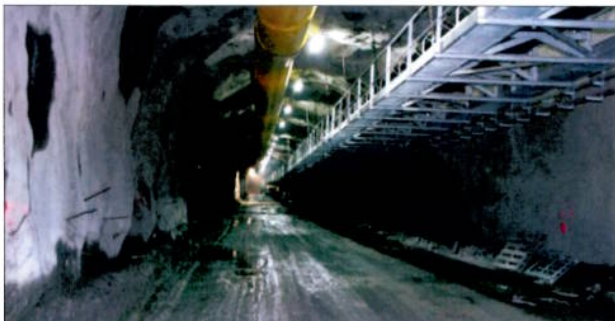
Fig 9- extracción de mineral triturado al exterior por medio de cinta transportadora en la galería de cota 195. Sistema pozo-túnel.
