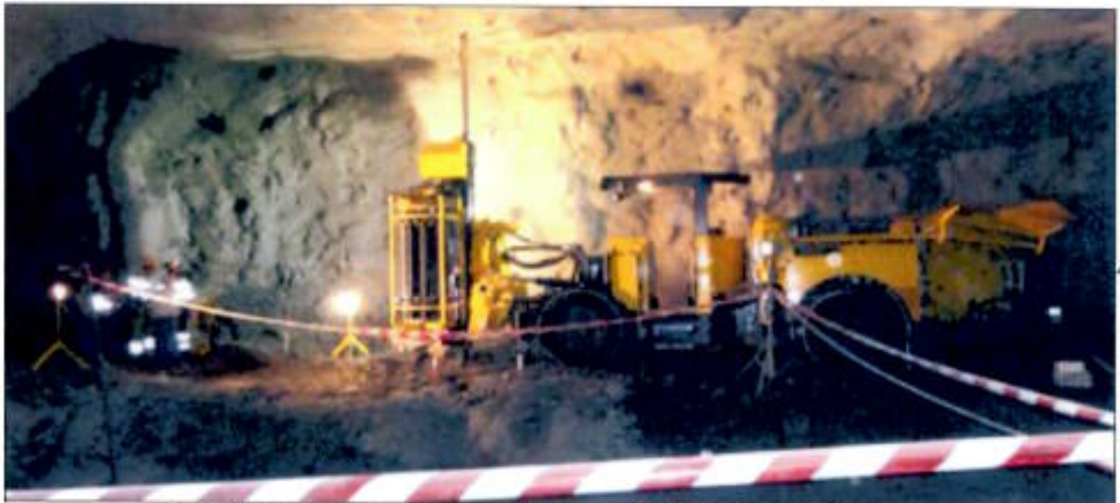
Fig 11- labores de perforación en banqueo en cámaras con perforadora "Simba". Explotación subterránea.
