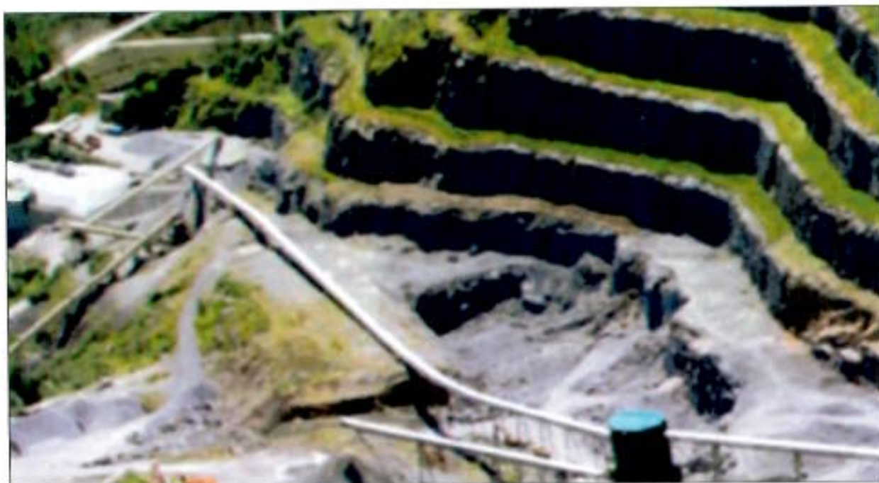
Fig 6- visual de la cinta descendente a prestlock (longitud de 470 m con un desnivel negativo de 60 m). Generación al año de más de 250.000 kwh en baja tensión que se recupera para el consumo en otras máquinas de la instalación.
